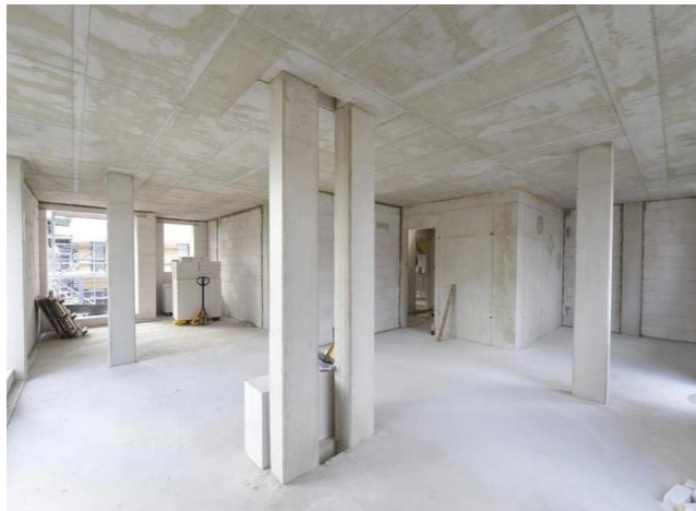
Design for building reuse Grundbau & Siedler, Hamburg
